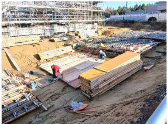
・コンクリート型枠組立状況 (令和7年12月18日 撮影)
