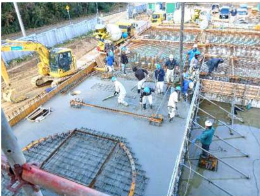
・コンクリート打設状況 (令和7年12月09日 撮影)
