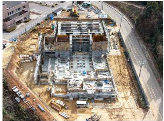
・コンクリート型枠組立状況 (令和7年12月18日 撮影)
